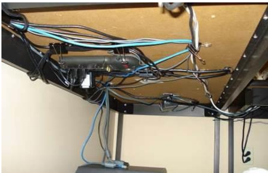
Рисунок 4 – Крепление кабелей к столешнице с помощью клипс на саморезы и двухсторонний скотч
