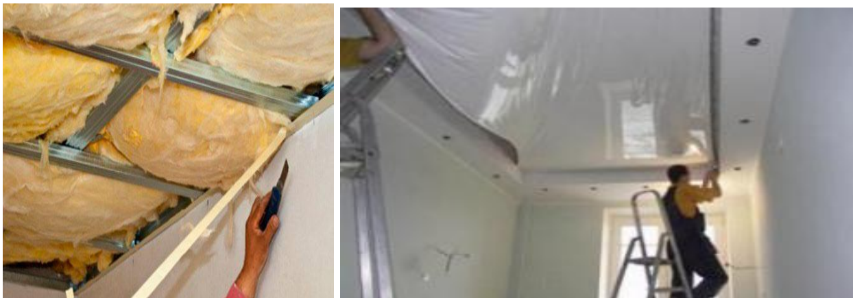
Рисунок 5 – Утепление потолка и установка натяжного потолка
