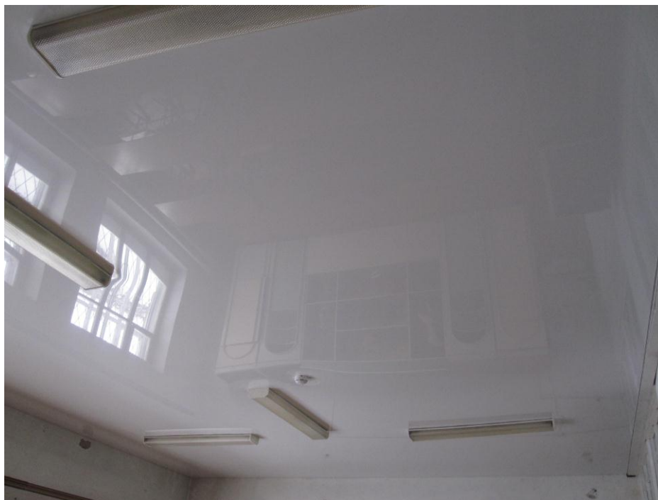
Рисунок 6 – Фотография реализованного проекта монтажа натяжного потолка (вид со стороны оконных проемов)
