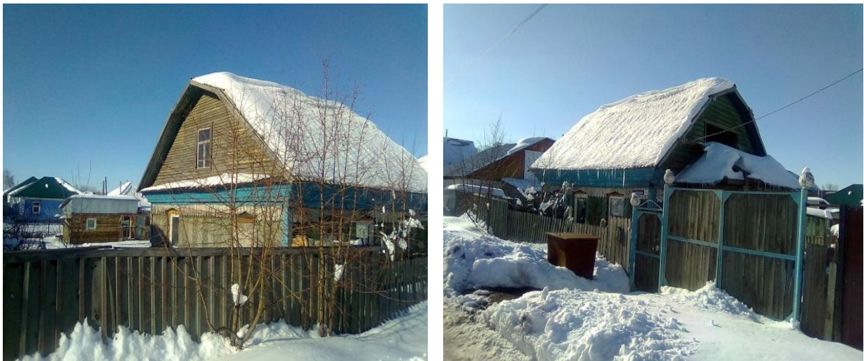
Рис. 6. Объект исследования (слева – южная сторона дома, справа – восточная)
